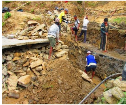
(旧タンクを撤去した様子)
