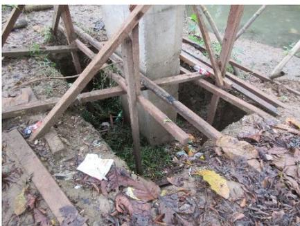
橋の強度を高めるため、柱の元にある空間を埋め立てた。作業の内容としては、埋め立て用の岩を橋付近の崖から削り出す作業、その岩を柱の元へ運ぶ作業、そしてそれを柱の元に空いた穴の中に入れ、最後にコンクリートで固める作業を行った。
