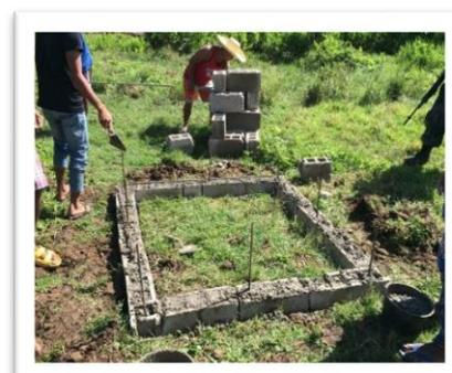
II 型が完成したらセメントに小石と砂と水を加えて混ぜた。最後に、セメントで周りを整えた。
