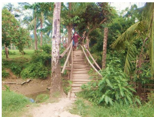
現在かかっている竹の橋
