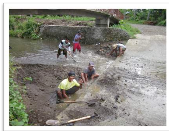
(土砂を除去している様子)
