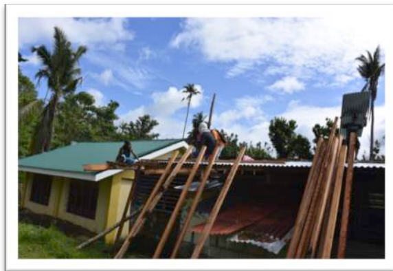
小学校の屋根の修理
