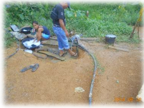
マラオの水道設備
