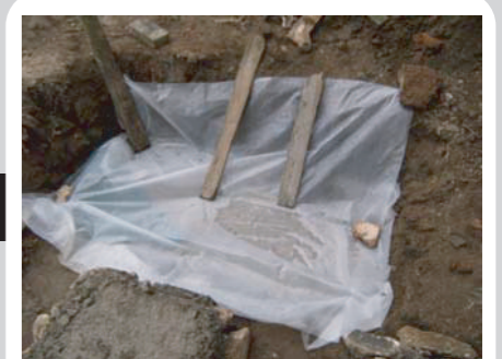
④肥溜めの床にビニールを引き、レンガとセメントで肥溜めの壁を作る。
