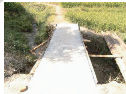
④木の板で作った枠にセメントを流し込み完成！
