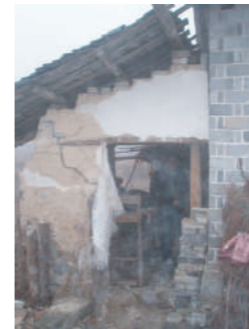
①既存のトイレを壊す。 ②肥溜めと便器になる部分に穴を掘る。
