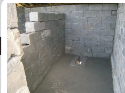
⑧床をセメントで固める。
