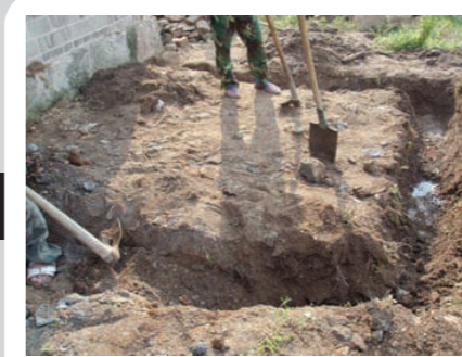
③壁となる部分に溝を掘り、そこに石とセメントを入れ、壁の土台を作る。
