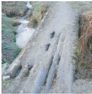
①既存の丸太を並べた橋を壊し、隣に臨時の丸太で作った橋を並べる。
