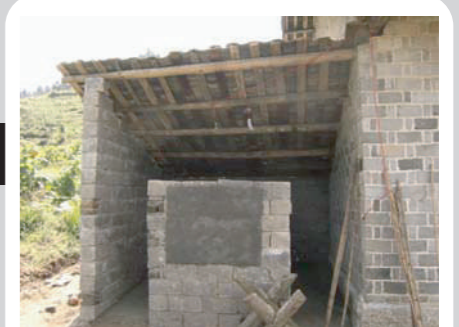
⑨電気を設置して完成！
