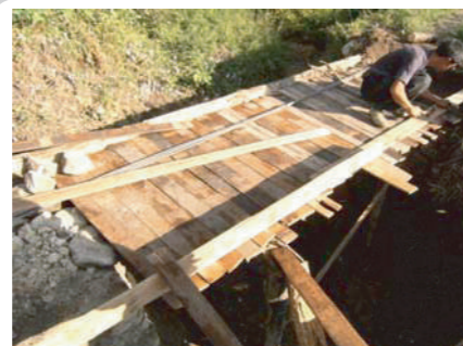
③木の板で橋の枠を、木の板と丸太で支えを作る。
