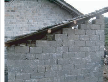
⑦木で屋根の基礎を作り、そこに瓦を並べる。
