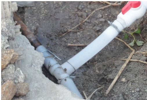
元の水道管を枝分けして2本にした
