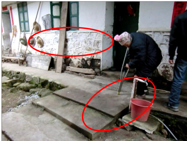
・手すり予定場所
