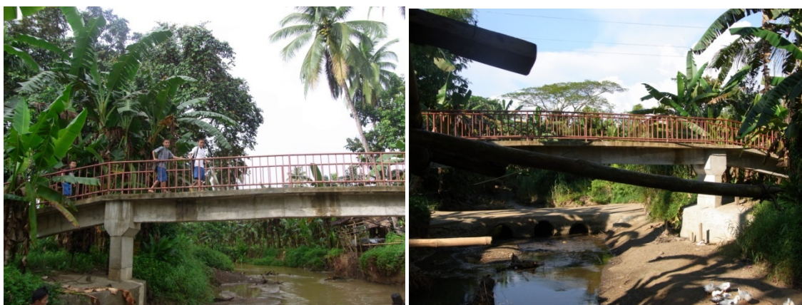
*現在の橋の様子
