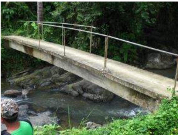
サンドニシオ村の Foot Bridge
